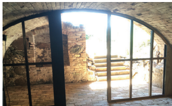
Blick aus dem Gewölbe
